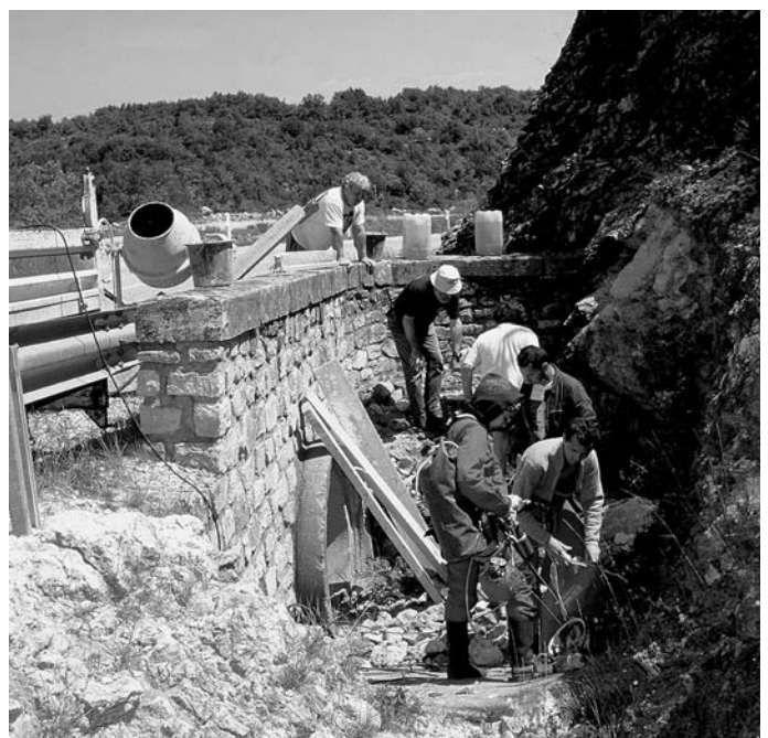
Buse, travaux zone d'entrée. Photographie Thierry Aubé.
